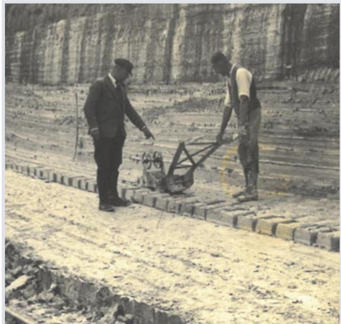
Arbeiten am »Tonpflug«, zum strangweisen Abbau von Ton in den 50er Jahren.
