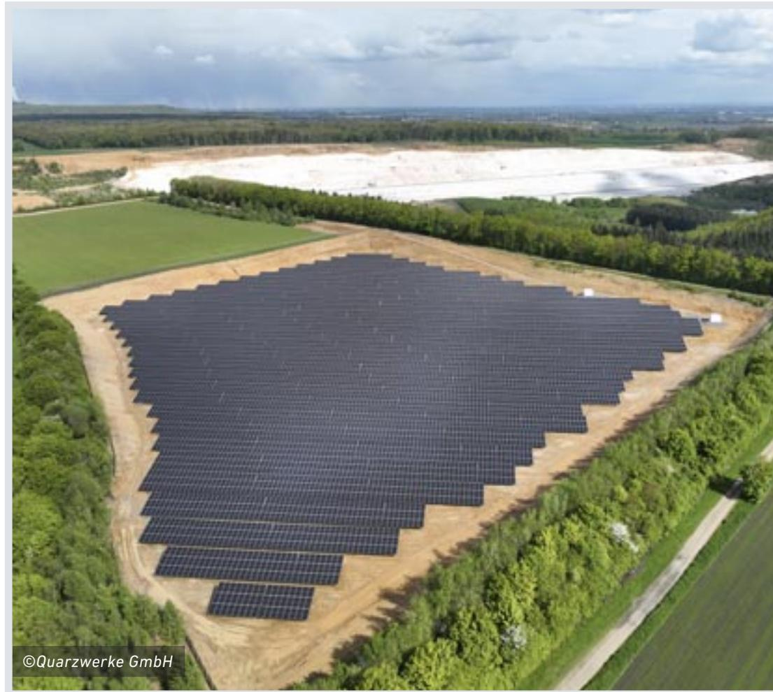
*Rohstoffgewinnung mit grüner Energie. Die PV-Anlage in Frechen verfügt über eine installierte Nennleistung von 6,5 Megawatt-Peak und liefert einen jährlichen Ertrag von rund 6,59 Gigawattstunden. Auf einer Gesamtfläche von circa 30.000 Quadratmetern wurden 11.352 Module errichtet.*
