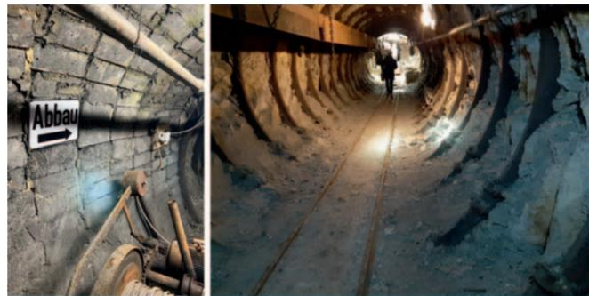
Die Hauptstecken sind gemauert, bis zum Abbauort mit Metallstreben gesichert.
