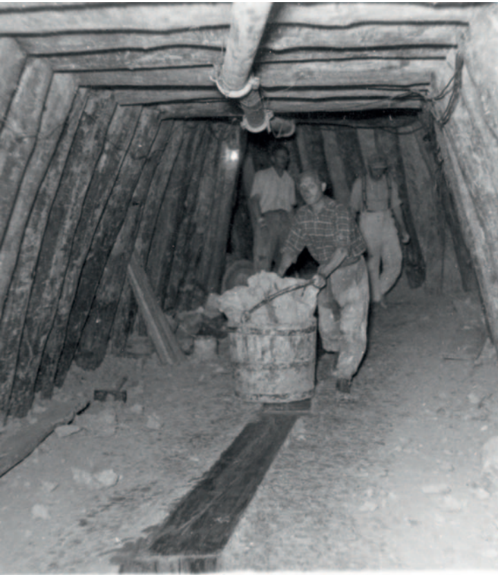
Untertägige Strecke mit Stempelausbau, ca. 1930
