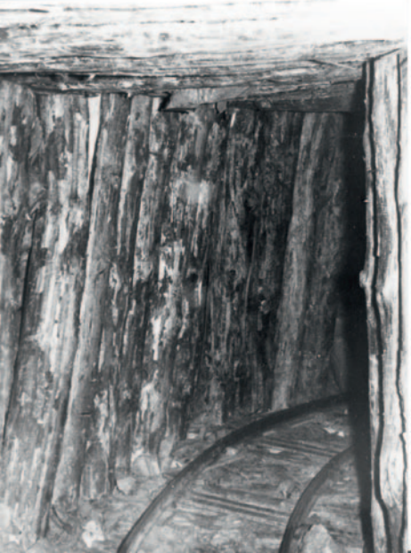
Streckenausbau mit Holz, Schacht Alois, Berod, Fa. A. J. Müller, Jahr unbekannt (Foto: Tonbergbaumuseum)
