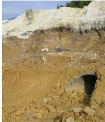
Die mit Keilsteinen gemauerte Förderstrecke zeigt aber auch die solide Bauweise früherer Tage. Die hier angetroffene Strecke, zumindest soweit sie momentan zugänglich war, ist in einem verhältnismäßig guten Zustand. Dies ist zurückzuführen auf die im Untertage übliche Herstellung der Ausmauerung, zu der in mühsamer Handarbeit Schablonen verwendet wurden, um die Keilsteine richtig zu positionieren. Solche Schablonen sind im Tonbergbaumuseum in Siershahn zu sehen.
