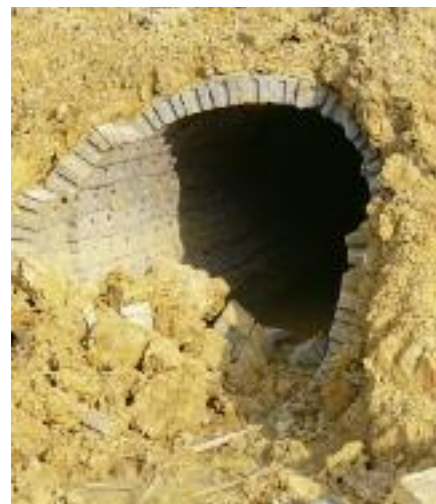
Gemauerte Strecke, Grube Lindenborn, Berod
