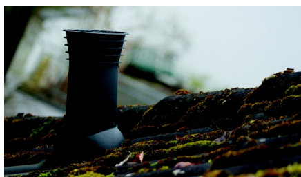
Typisches Dunstrohr als Entlüftung
